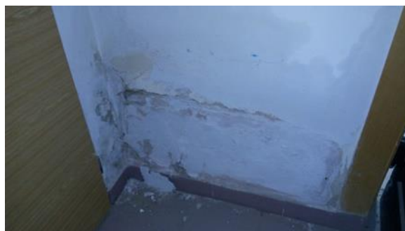
Viditelné projevy vlhkosti v 1.NP na stěně mezi podsklepenou a nepodsklepenou částí
