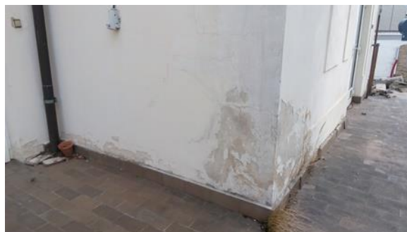
Zatékání z povrchu terasy
