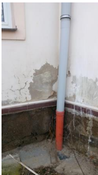
Poškození fasády způsobené zatékáním z porušených střešních svodů v minulosti
