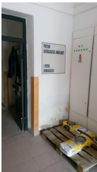
Poškození omítky v soklové části stěny v 1.NP
