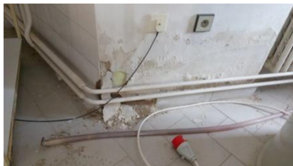
Viditelné projevy vlhkosti v 1.NP na obvodové stěně
