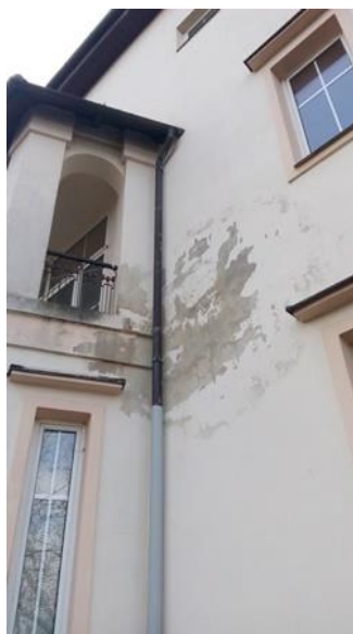
Poškození fasády způsobené zatékáním z porušených střešních svodů v minulosti
