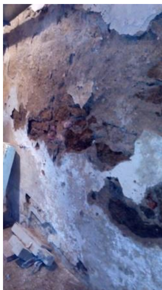
Úplně zdegradovaná omítka na stěně mezi podsklepenou a nepodsklepenou částí v 1.PP
