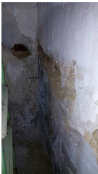
Poškození omítek ve sklepě
