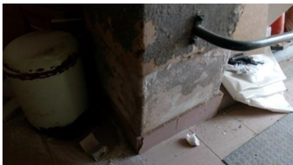
Viditelné projevy vlhkosti na vnitřní stěně v 1.NP
